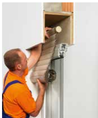
Alten Rollläden aus dem Kasten entfernen.
